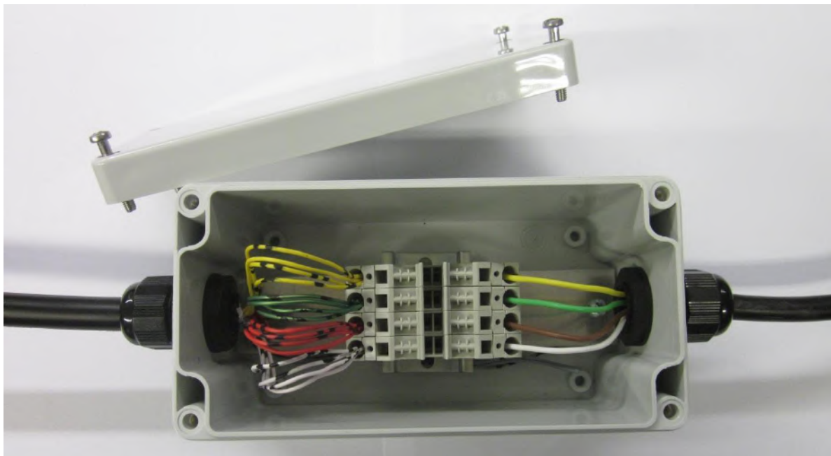
Abbildung 5: Beispiel einer Verlängerungsbox
