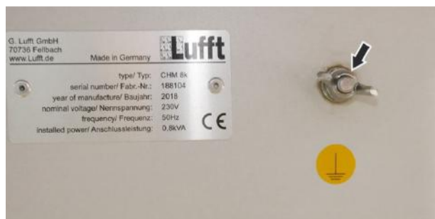
Abbildung 10 Erdanschluss
